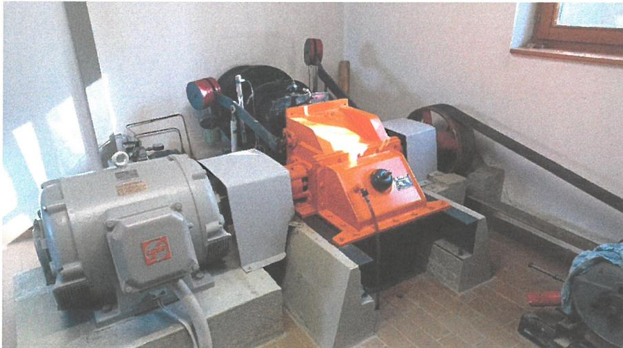
Durchströmturbine System „Ossberger“ mit Generator
