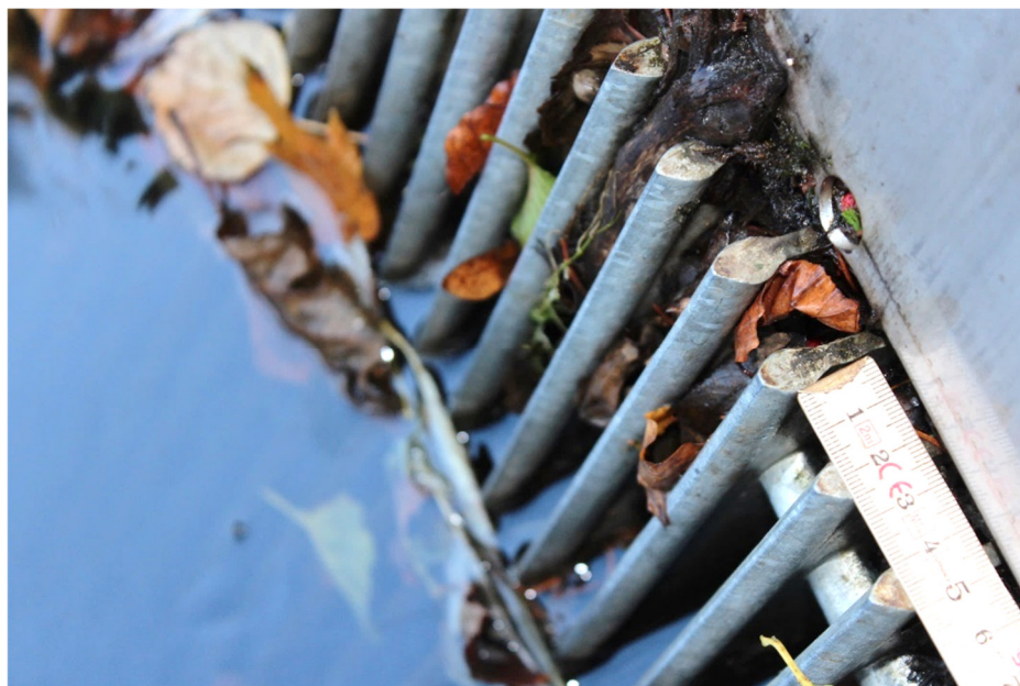
Neue Feinrechenanlage 15mm lichter Rechenstababstand
