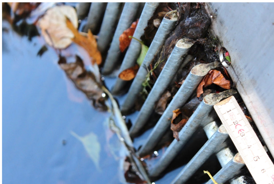
Neue Feinrechenanlage 15mm lichter Rechenstababstand
