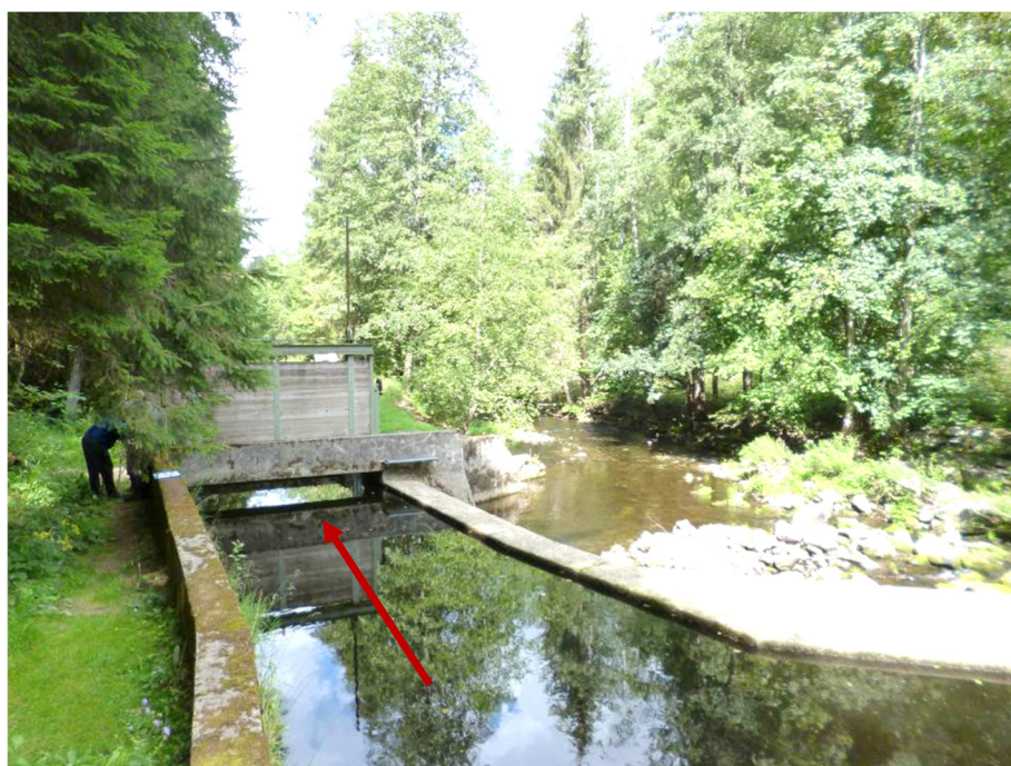
Wehranlage linker Teilbereich, Kanalausleitung
