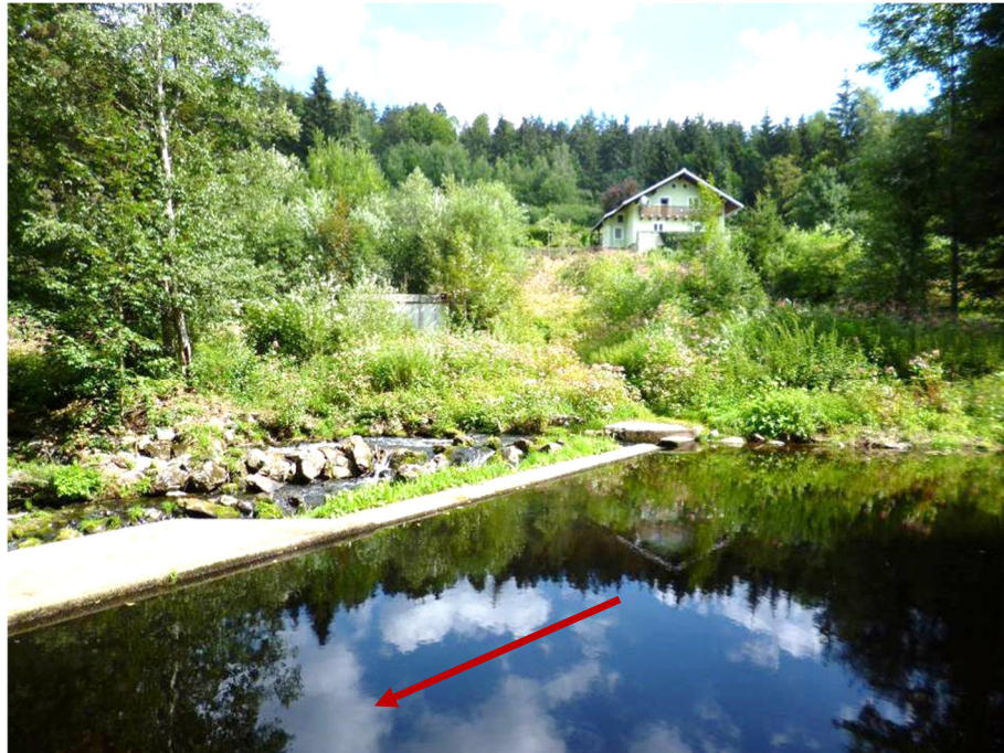
Wehranlage rechter Teilbereich
