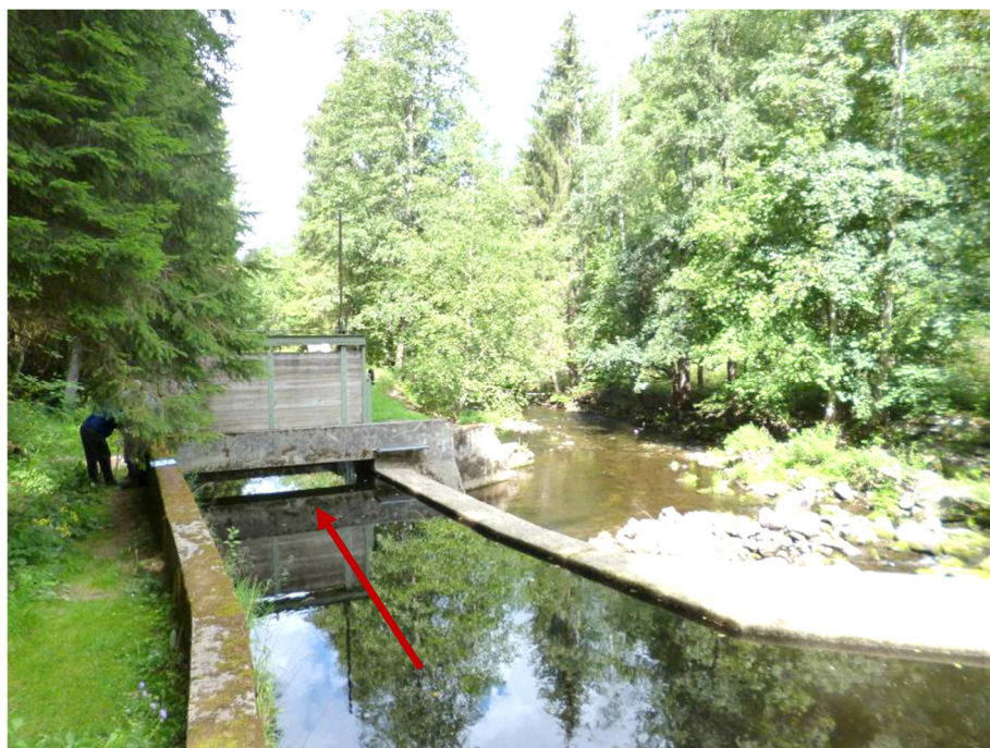
Wehranlage linker Teilbereich, Kanalausleitung
