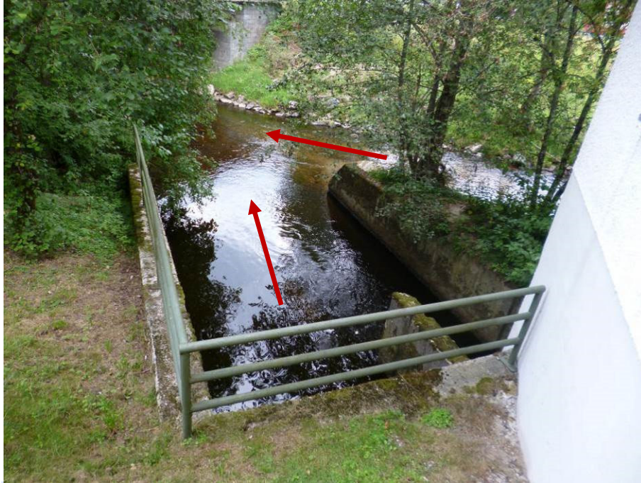
Unterwasserkanal und Mündung ins Altbett
