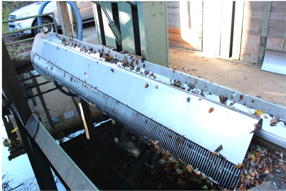
Neue Feinrechenanlage 15mm lichter Rechenstababstand
