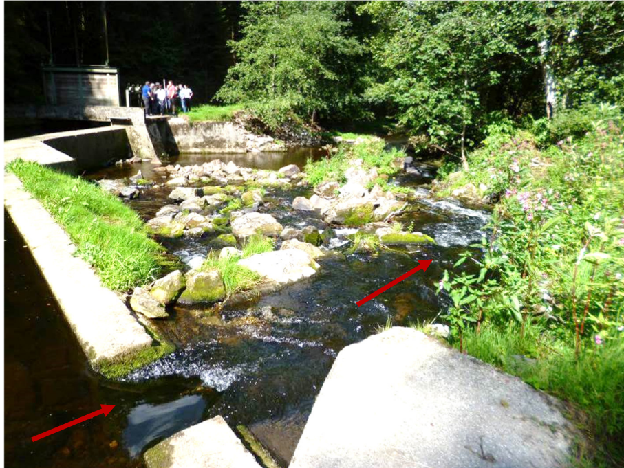
Wehranlage mit Einlaufbauwerk und best. Fischaufstiegshilfe wird künftig mit 20 l/s beaufschlagt
