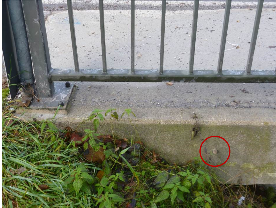
Amtlicher Höhenbolzen Brücke Saußbach
